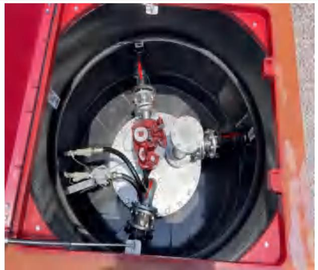
图 6 油罐操作井-汽油罐
