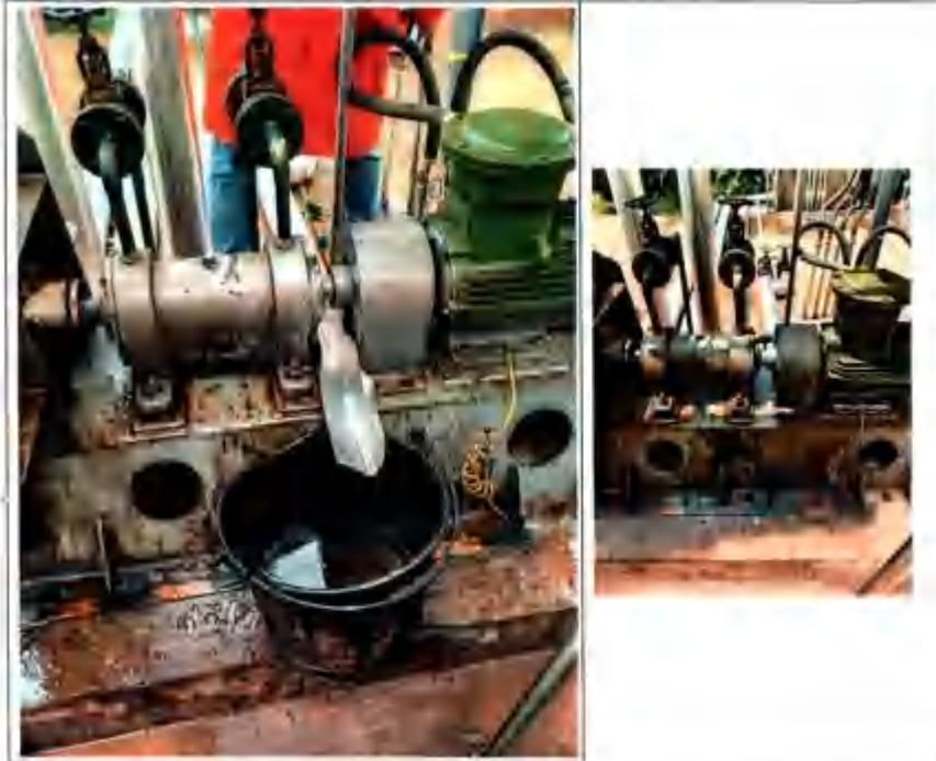
(9) VOCs 洗油管线过滤器未设置跨接线。
