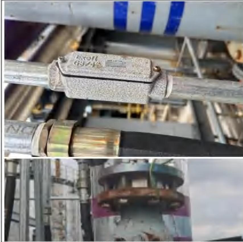
(3) 部分 VOCs 输气管道未进行介质、流向和介质名称进行标识；
